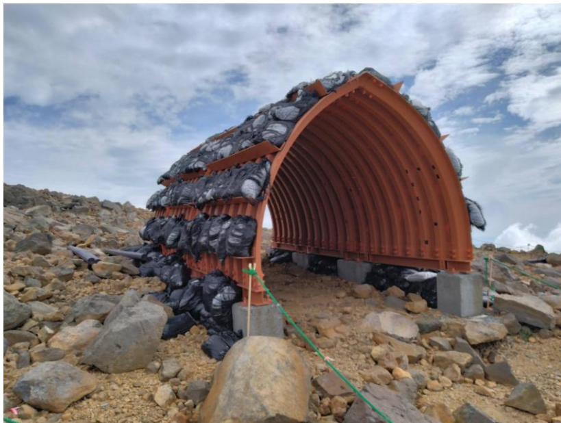
噴石避難用のシェルター、 屋根には防弾チョッキの素材のものが敷かれている
